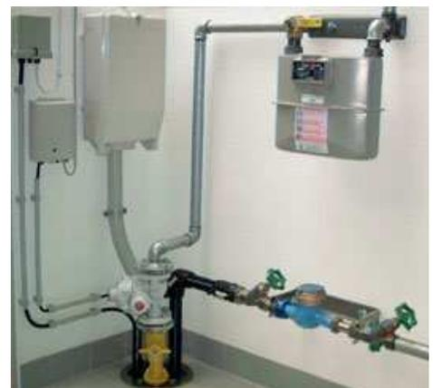
Mehrsparte für Strom, Wasser, Telekommunikation und Gas, runde Ausführung
