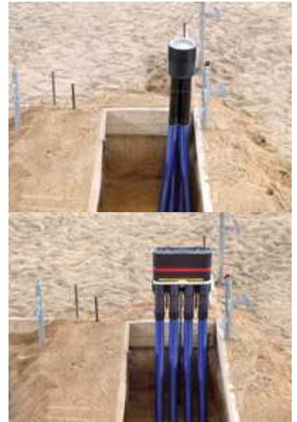
Das Außenbauteil (für runde oder eckige Mehrsparte) wird in die Bodenplatte einbetoniert. In die angeschlossenen Leerrohre können die Versorgungsunternehmen jederzeit ihre Versorgungskabel und -rohre verlegen.
